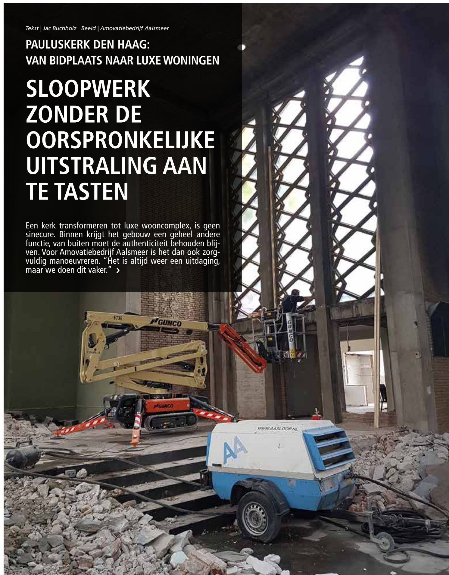
Kenmerkende details blijven behouden en ook het gevelbeeld blijft grotendeels intact.
